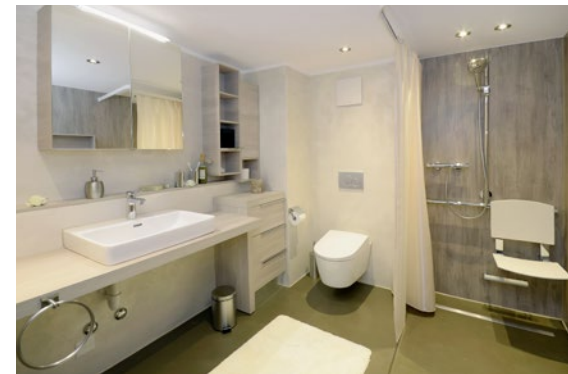
Grosse, hindernisfreie Nasszelle mit Dusch-WC, Dusche mit Haltestangen und Klappsitz.
